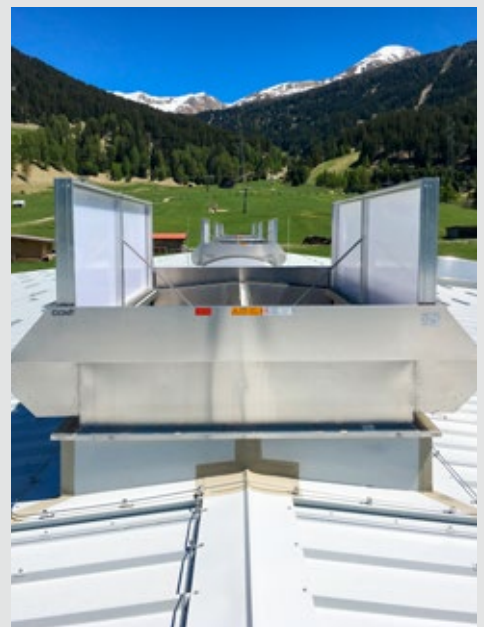
Brandlüftungssystem Apollo ATI mit regensicherer Lüftung
